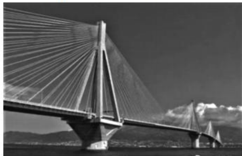
图 1 Rion-Antirion(里永·安蒂里永)大桥(图片来源:网络)
